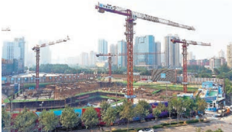
■瀋陽市昨日發佈樓市政策，從稅費到信貸等多方面支持鼓勵個人購房。圖為瀋陽一在建設項目。資料圖片
