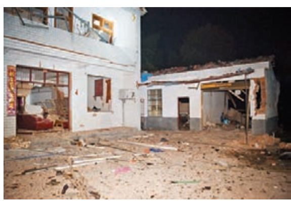
■距離事故現場不足10米的村民房屋因爆炸衝擊波而受損。中新社
