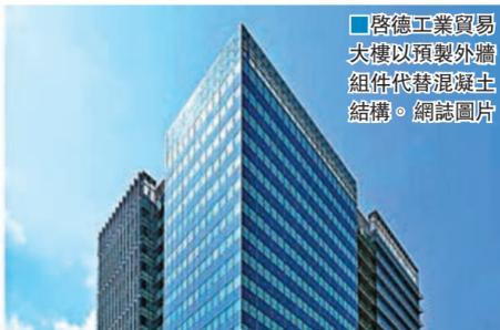
啟德工業貿易大樓以預製外牆組件代替混凝土結構。網誌圖片
