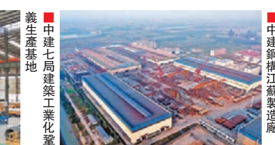
中建建七局建築工業化養生產業基地
