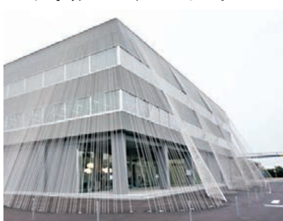
大樓主體為混凝土，以碳纖維作地基，並由海綿狀陶瓷物料包圍。
