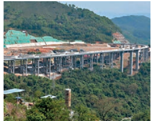
京福線後經進一步規劃,延伸為京台線。圖為京台高速公路福州段。資料圖片
