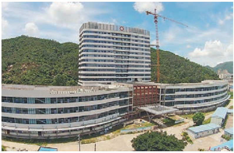
■建設中的金灣區人民醫院
