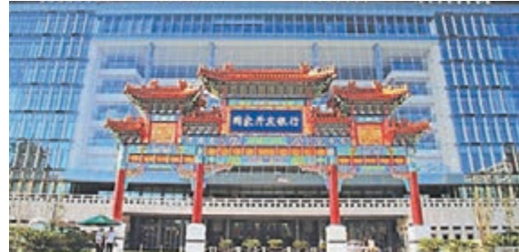
■上圖為拆除前的牌坊。下圖為工人在連夜拆除牌坊。
