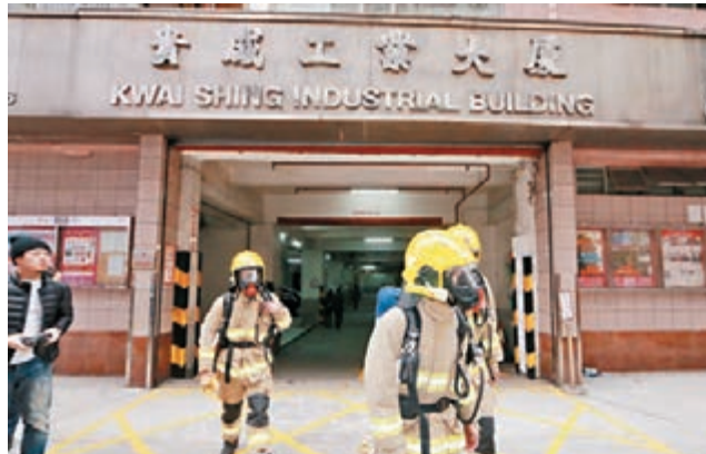
■消防員全副煙帽裝備到達發生三級火警的大連排道工廠。鄧偉明 攝
