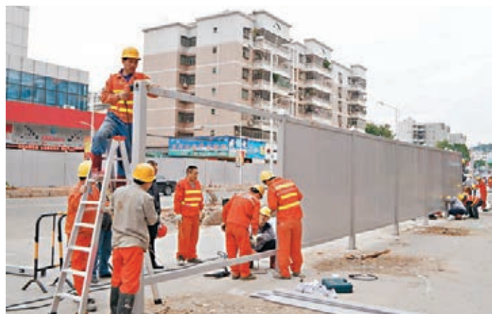
10號線平湖中心站開工，將成為「亞洲最長地鐵站」。本報深圳傳真
