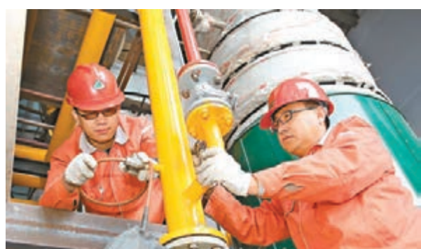
專家呼籲,治理大氣污染須提高天然氣比重。圖為河北張家口,工人正在調試天然氣鍋爐。 資料圖片
