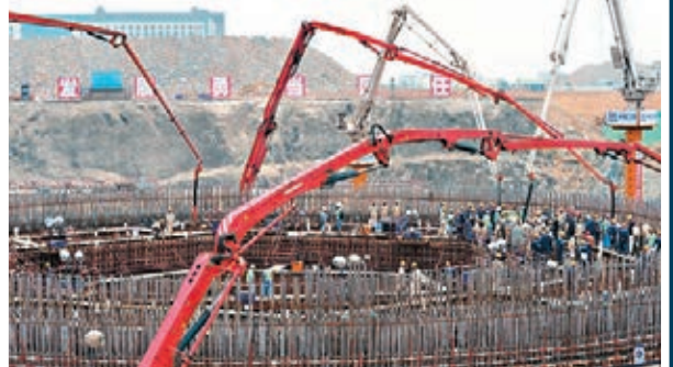
福建福清5號核電機組進行建設。福清5號核電機組是中國自主三代核電技術「華龍一號」示範工程。資料圖片
