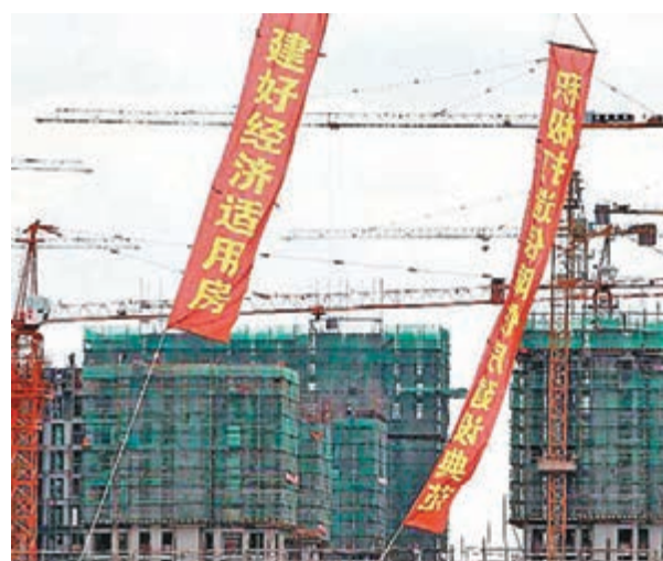
目前廣東省總債務率低於國際風險控制標準。圖為廣東一保障性安居工程施工地。資料圖片
