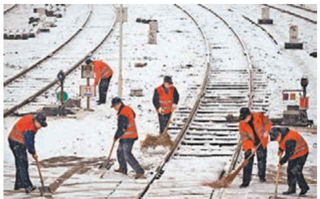
■江西南昌鐵路局派出多名工人清掃九江客技站軌道上的積雪，確保旅客出行安全。 新華社
