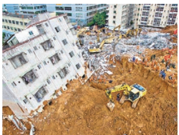
■深圳塌山泥事故最後通緝犯自首。圖為塌山泥事故現場。資料圖片
