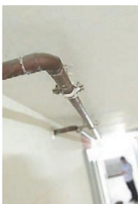
■多條公屋的食水管接駁位被驗出了含鉛燒焊料。資料圖片
