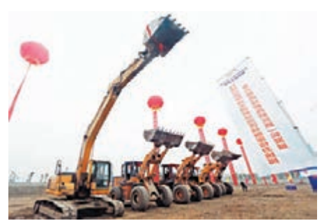
整齊排列的挖掘機開工啓動。
