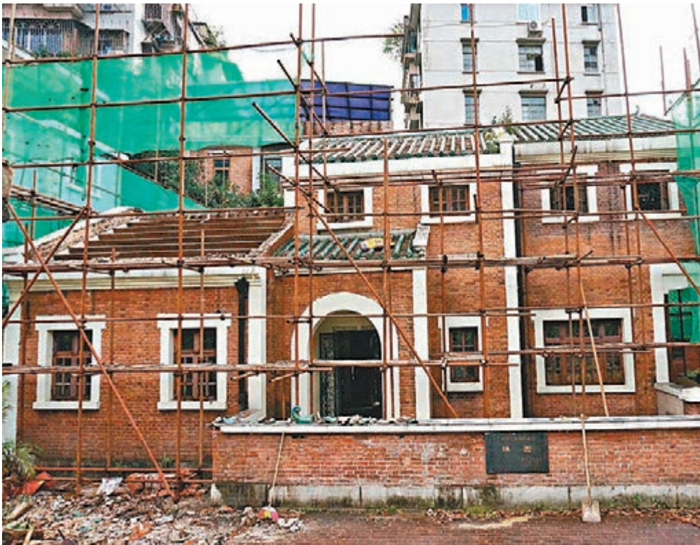
■隅園部分瓦片已被拆除（左方），園內建築垃圾滿地。
