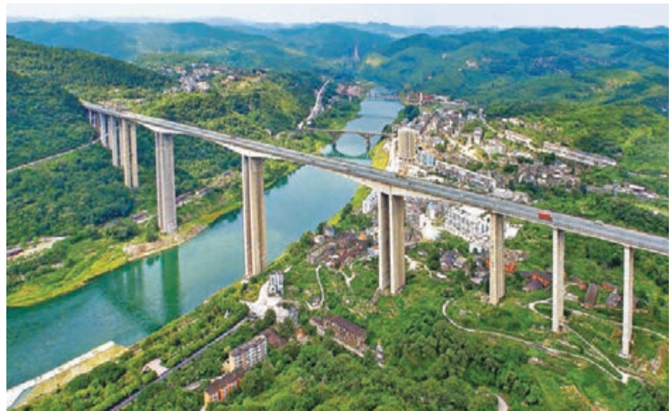
歷時7年建設,貴州成為內地西部首個實現「縣縣通」高速的省份。圖為蘭(州)海(口)高速貴州境內段烏江大橋。
