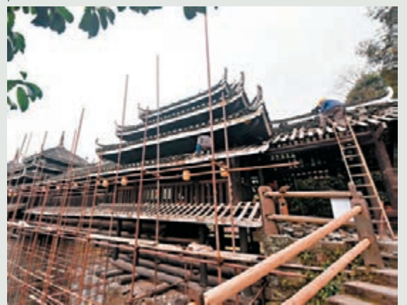
廣西三江侗族自治縣林溪鎮程陽永濟橋昨日開始了為期90天的封閉維修。該橋1982年被國務院公佈為全國重點文物保護單位,與趙州石拱橋、瀘定鐵索橋以及羅馬尼亞諾娃沃鋼索橋並稱世界四大歷史名橋。圖為昨日,侗族群眾在該橋上拆卸舊瓦片。 ■新華社
