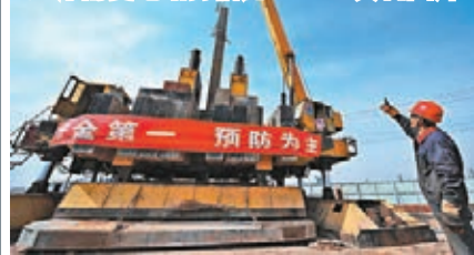
煤電價格後天將下調。圖為工人在天津南變電站打樁施工。資料圖片
