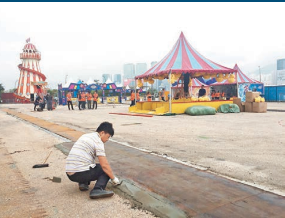
■不少機動遊戲及攤位未準備就緒，昨仍有工友在場內鋪水泥及電線。
