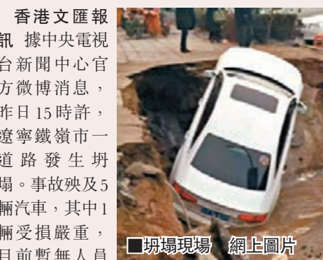
塌塌現場。網上圖片
