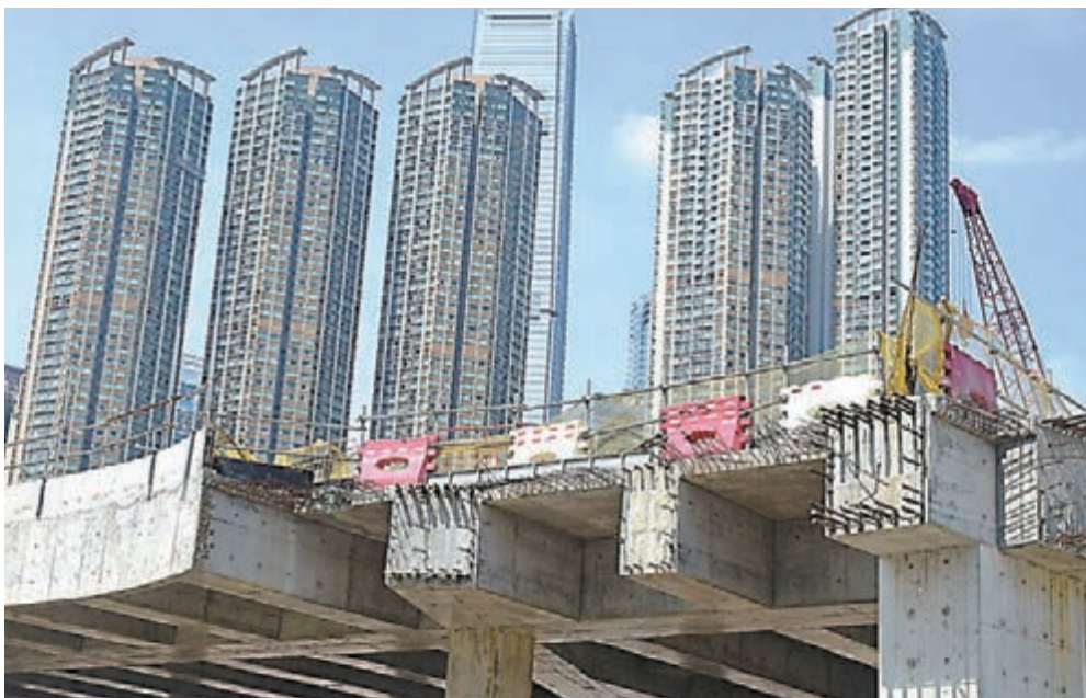
廣深港高鐵香港西九龍站施工地盤。
