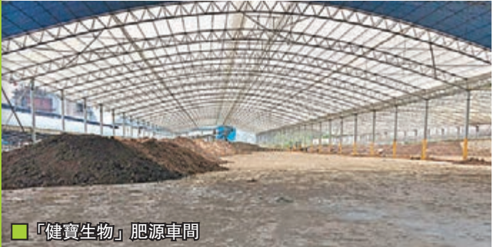
「健寶生物」肥源車間
