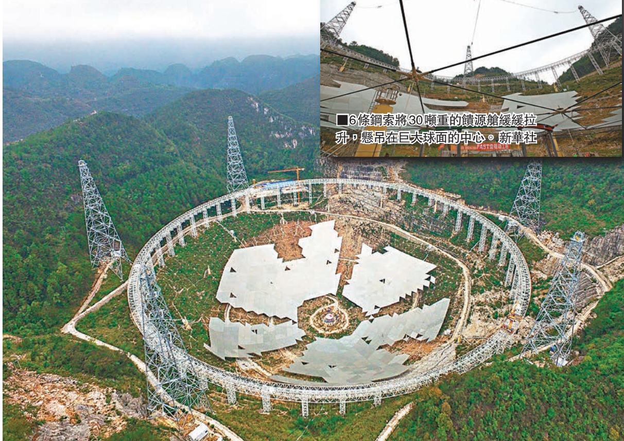
鋼索拖動FAST饋源艙進行功能性測試。新華社
