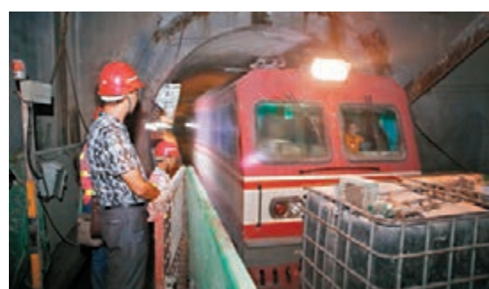
深圳地鐵7號線軌道上行駛的施工車。記者郭若溪攝
