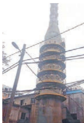
瀋陽市內的不小區裡，「火箭式」脫硫塔正在陸續建設，建成後除塵效果在99.9%以上，脫硫效果在95%至99%以上，基本可以實現污染物「零排放」。 記者于珈琳 攝
