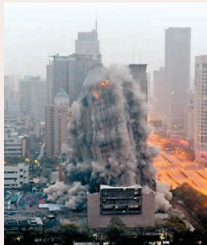
位於陝西西安市高新區的一座辦公大樓15日早7時成功爆破拆除，該大樓建築總高度為118米，爆破作業前後用時15秒完成。據爆破設計項目部介紹，樓內安裝1.4噸的定製炸藥和1.2萬枚雷管，採用三開口、延期爆破的方式，此舉不僅可以安全地將大樓爆破拆除，對周圍產生的振動以及衝擊波也較小。中新社
