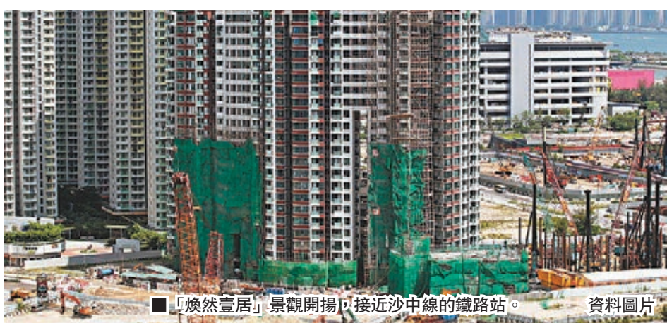
「煥然壹居」景觀開揚，接近沙中線的鐵路站。 資料圖片
