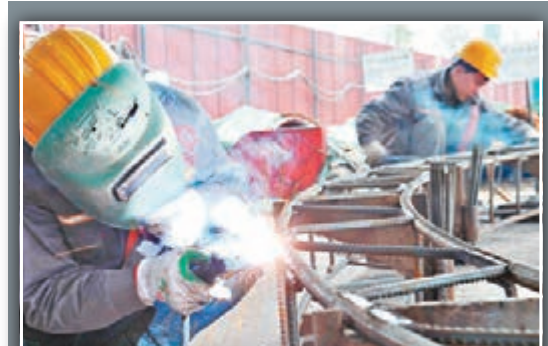
■南水北調通州工程開工 昨日，施工人員在南水北調通州支線工程現場焊接隔欄鋼架。近日，南水北調工程北京通州地區配套工程全面開工。配套工程主要由通州支線工程與通州水廠工程組成。 新華社
