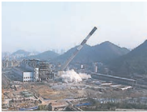
■貴陽電廠煙囪被爆破拆除。這是黔「守住生態底線」戰略的經典瞬間。本報貴陽傳真
