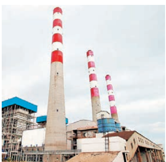
圖為中國機械設備工程股份有限公司作為承建和技術輸出方，在斯里蘭卡建設的燃煤電站。資料圖片
