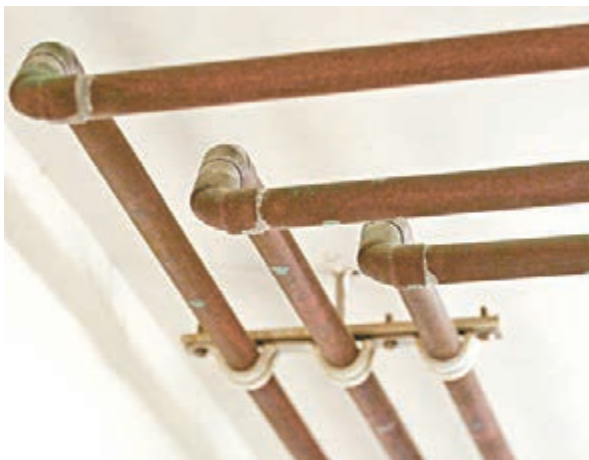
▲房署過往無注意到供水系統可能含鉛，所以未有把焊接物料列為高風險項目。圖為啟晴邨食水管焊接口。資料圖片
