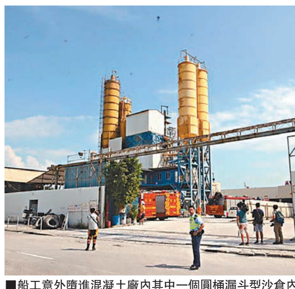
船工意外墮進混凝土廠內其中一個圓桶漏斗型沙倉內遭活埋。
