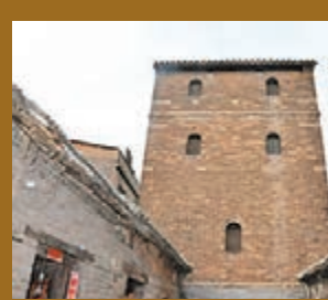
院落最深處一家之主的居室氣派如同朝堡。
