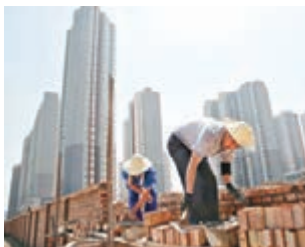
■城鎮保障性安居住房四年僅建成2,000萬套，進展明顯滯後。圖為山西太原西華苑保障房建設工地。資料圖片
