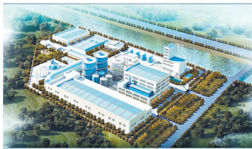
中聯重科在徐州市餐廚廢棄物資源化利用和無害化處理PPP項目鳥瞰圖。吳靖攝
