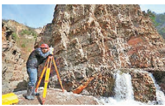
■在寧夏中南部城鄉飲水安全水源工程龍潭水庫加固改造現場，測繪人員在對即將搭建蓄水堤壩的位置進行測繪。 網上圖片
