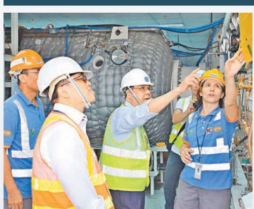
張建宗(左三)視察連接屯門及港珠澳大橋香港口岸的海底隧道地盤安全。
