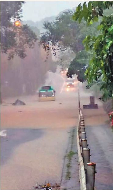
◀西貢大網仔路雨中發生護土牆坍塌，消防到場搜索是否有人被困。
