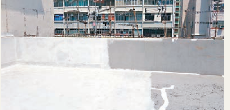
世界綠色組織為舊式唐樓天台地面作溫度測量，發現上月最高溫度接近80度。
