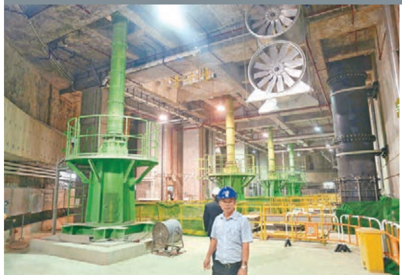
主泵房8台大型污水泵，總泵水能力每秒32立方米，只需1分鐘就能填滿一個標準泳池。
