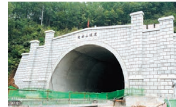
■老安山隧道已順利實現貫通。新華社
