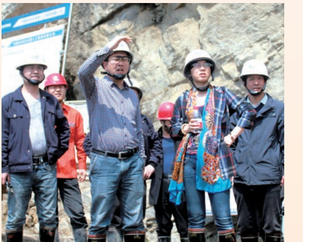
■李仁剛（左三）在工地現場跟進檢查施工進度和質量。
