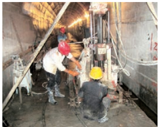
■平寨水庫帷幕灌漿防滲施工。圖由貴州省水利廳提供
