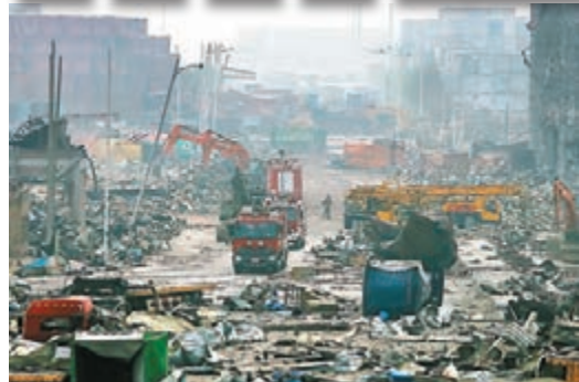
8月17日，救援人員在爆炸現場使用工程機械清除障礙。
