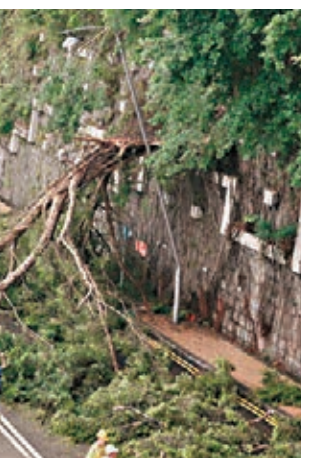
薄扶林道發生石牆樹倒塌現場。
