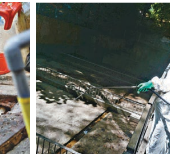
渠務署職員加強滅蚊。梁祖彝攝
