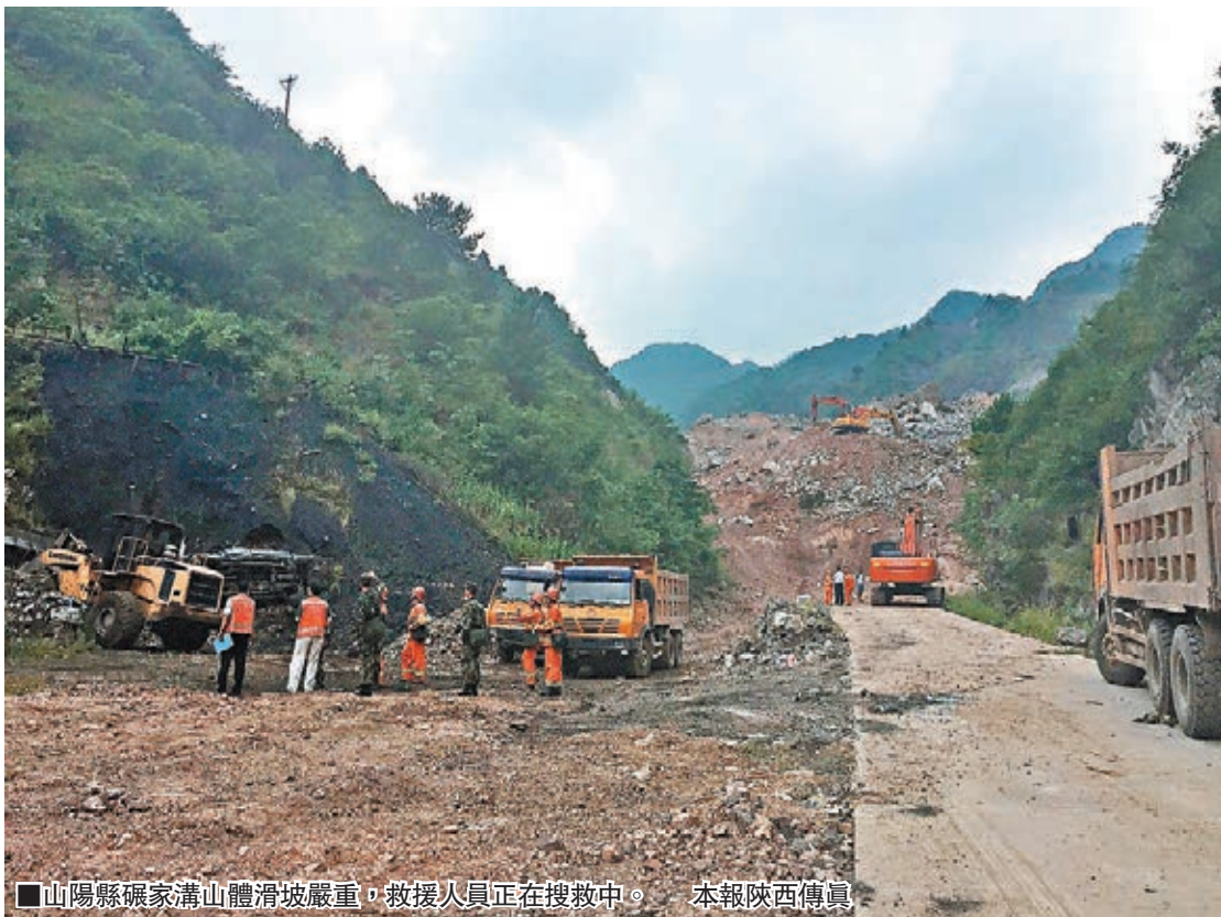
山陽縣碾家溝山體滑坡嚴重，救援人員正在搜救中。本報陝西傳真
